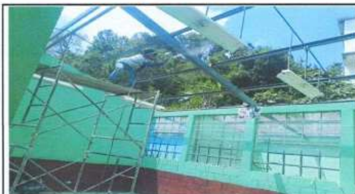
Foto 4: Cambio de laminas
