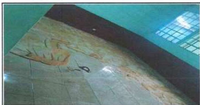
Foto 5: Sisado de piso cerámico
