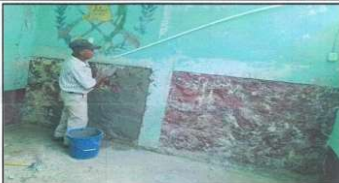
Foto1: Restauración de paredes
