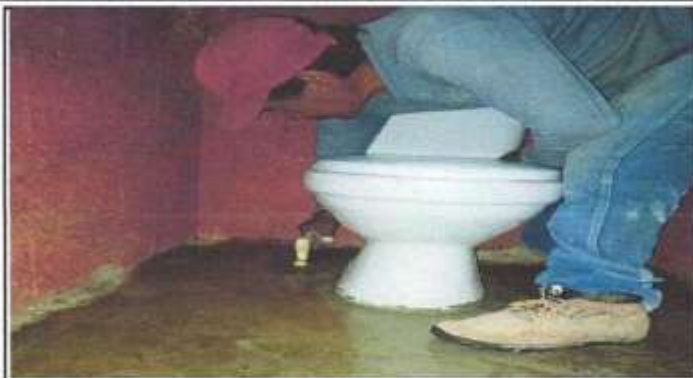
Foto 2: instalación de sanitario
