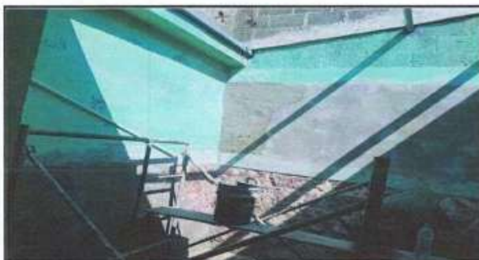
Foto 3: Repello de paredes de las aulas
